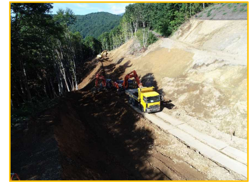
⑨ 鳥海ダム大膳ヶ沢地区工事用道路工事
