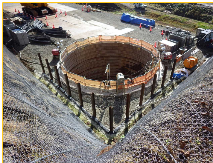
③鳥海ダム付替道路4号橋下部工(P1)工事
