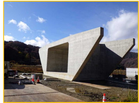
⑧ 鳥海ダムダムサイト工事用道路工事
