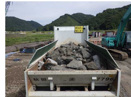
コンクリート塊の搬出状況
