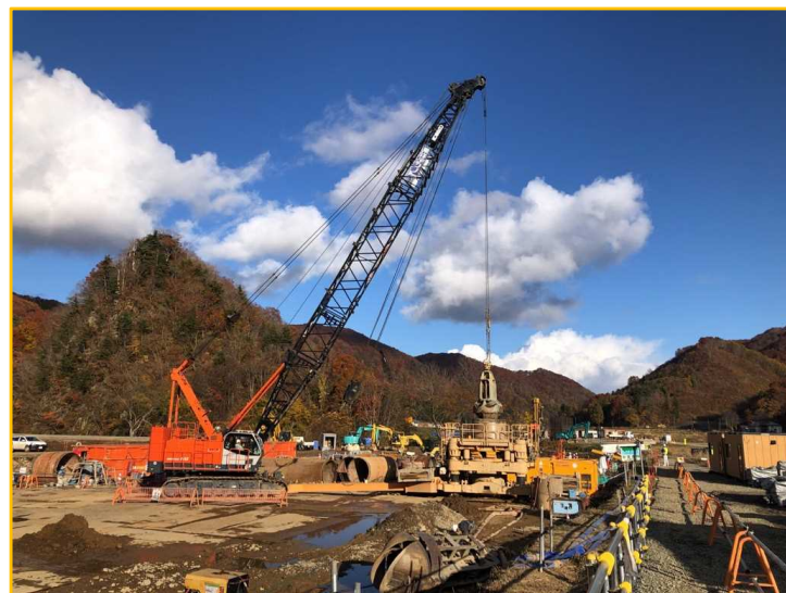
②鳥海ダム仮締切(地中壁)工事
