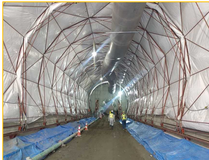
①鳥海ダム仮排水トンネル工事(坑内)
