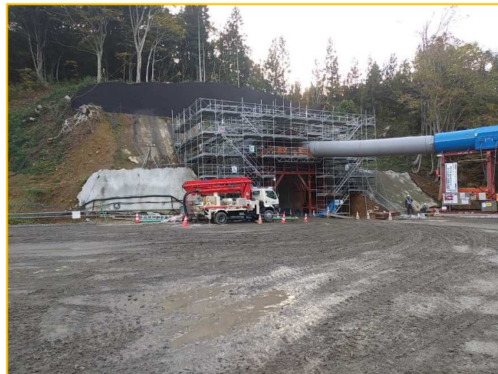
①鳥海ダム仮排水トンネル工事(吐口)
