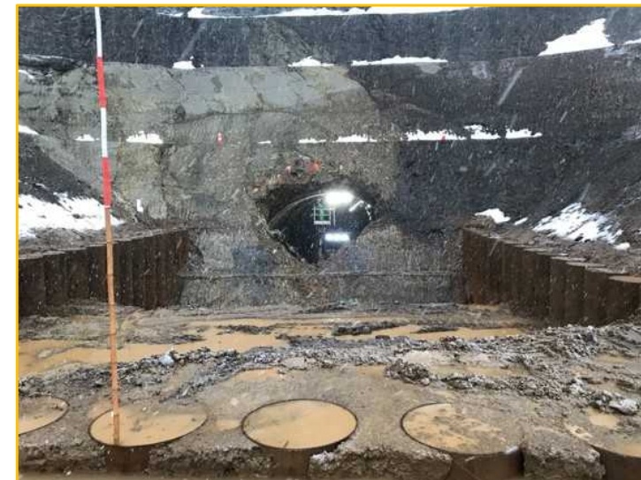
①鳥海ダム仮排水トンネル工事(呑口)
